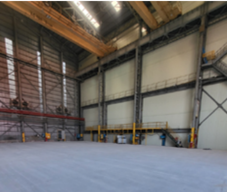
<대면적 바닥 구조물> 대면적, 무줄눈 구조물에서 수축균열 저감
